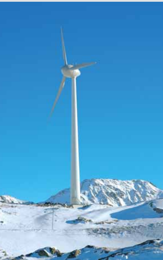
Impianto di energia eolica sul Gütsch sopra Andermatt (proprietà della Elektrizitätswerk Ursern, Andermatt)
